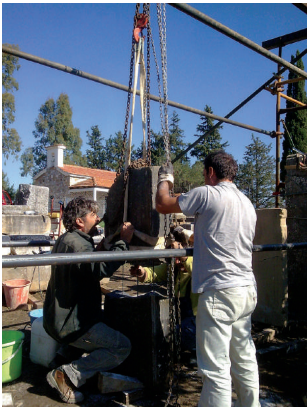
Εικ. 5. Εργασίες συντήρησης ενός ορθοστάτη του θρόνου.
